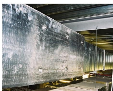
kraju prelepe samolepljivom aluminijskom trakom, kako bi se postigla celovita parna brana i optički izgled.
