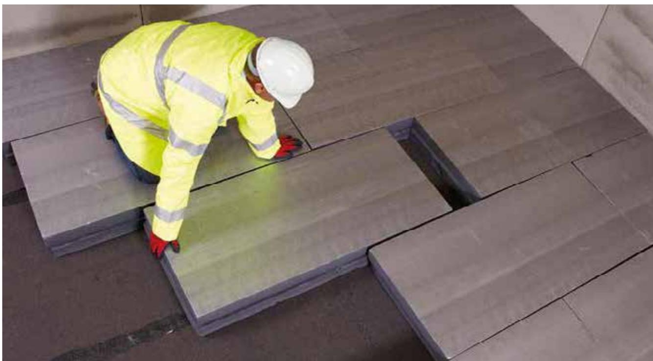
Le lastre RAVATHERM™ XPS X sono prodotte in polistirene espanso estruso. Il processo di estrusione produce una struttura uniforme di piccole celle chiuse che conferiscono a RAVATHERM™ XPS X peculiari caratteristiche. Tutti i prodotti RAVATHERM™ XPS X soddisfano i requisiti imposti dal regolamento europeo EC\2037\2000 del 29/06/2000 sulle sostanze dannose per lo strato di ozono.
