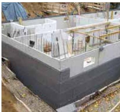
Fig. 03 - Isolamento di pareti controterra
