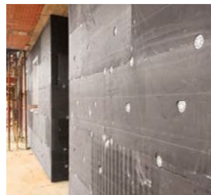
Fig. 04 - Isolamento a cappotto
