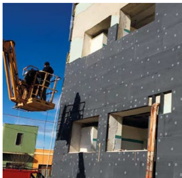
Fig. 05 - Isolamento a cappotto, Scuola di salice salentino
