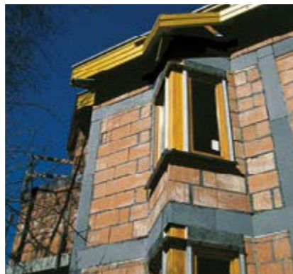
Fig. 01 - Isolamento dei ponti termici
