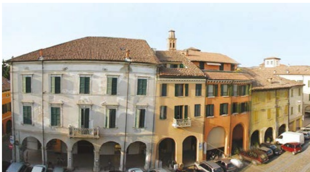
Ristrutturazione di tetti a falde
