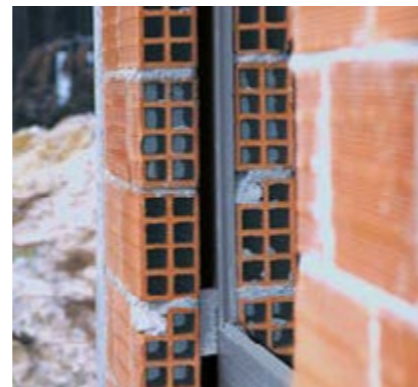
Fig. 02 - Isolamento in intercapedine
