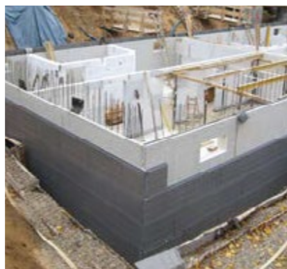
Fig. 03 - Isolamento di pareti controterra
