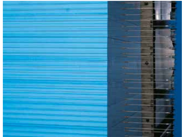
Abb. 09: Schneiden von RAVATHERM XPS mit einer Heißdrahtmaschine
