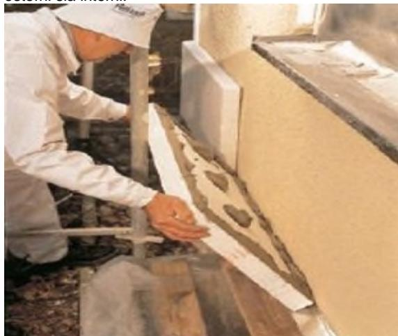
**Importante:** non utilizzare MasterEmaco ADH 290 su polistirene estruso con pelle o pannelli termoisolanti rivestiti con film di plastica o carta.
