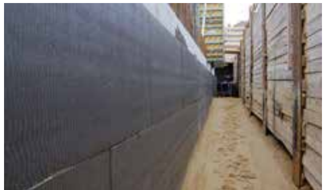
Abb.10: Graue XPS Dämmplatten auf der Kelleraußenwand verklebt
