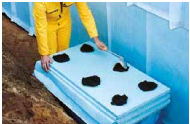
Abb. 28: Punktweise Verklebung der Perimeterdämmung
