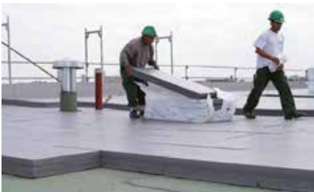
Abb. 14: RAVATHERM™ Platten werden zweilagig verlegt
