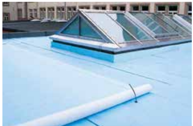
Abb. 28: Lose Verlegung der Trennlage
