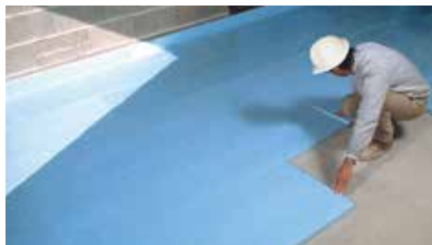
Abb. 46: XPS-Bodendämmung in einer Sporthalle
