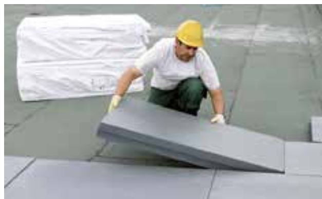
Abb. 44: XPS Platten lassen sich leicht handhaben
