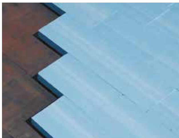
Abb. 17: Umkehrdach auf bituminöser Abdichtung
