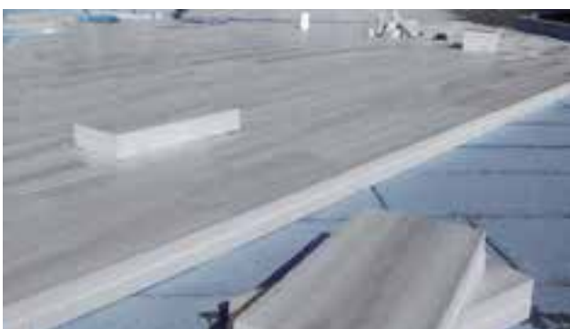
Abb. 45: XPS Platten werden lose verlegt
