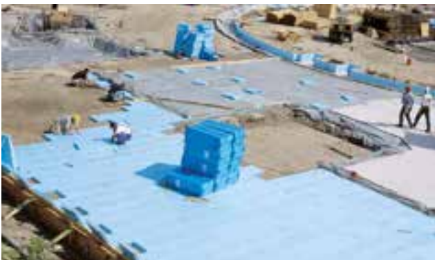
Abb.09: XPS Dämmplatten lose auf der Beton-Sauberkeitsschicht verlegt
