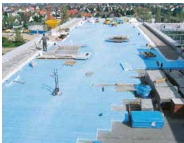
Abb. 19: Verlegung von XPS Platten im Verband. Die Windsogsicherung wird im Randbereich aufgebracht.
