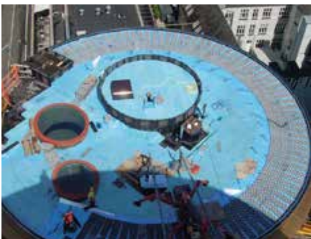
Abb. 16: XPS-Dämmplatten auf dem Dach vom Axeltorv-Haus, Kopenhagen
