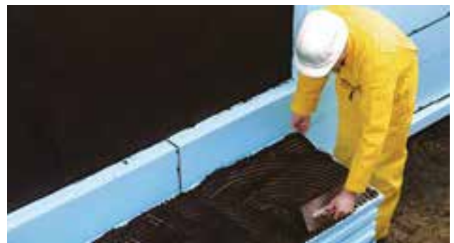
Abb. 32: Vollflächige Verklebung der blauen XPS Dämmung
