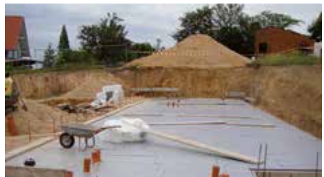
Abb. 19: Verlegung XPS-Dämmplatten unter lastabtragender Bodenplatte
