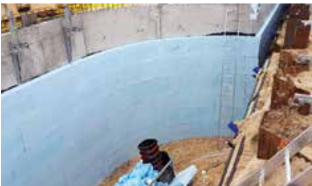
Abb.11: Dämmplatten auf der Kelleraußenwand verklebt
