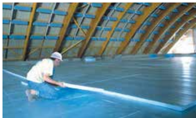
Abb. 45: XPS-Bodendämmung in einer Sporthalle
