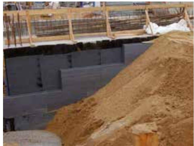
Abb. 17: Verklebung der XPS Dämmplatten auf der abgedichteten Kelleraußenwand
