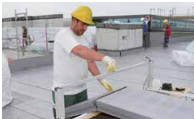
Abb. 15: Die RAVATHERM™ Platten werden mit dem Heißdraht geschnitten
