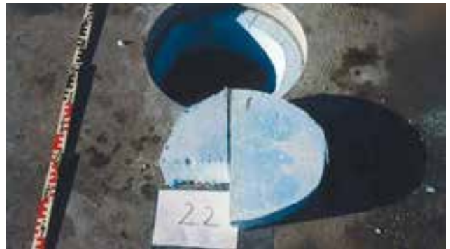
Abb.51: ... aus dem Parkdeck des Einkaufszentrums Pariser Straße, Kaiserslautern
