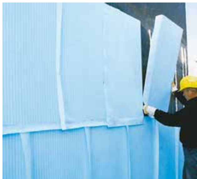
Abb. 34: Verlegung der blauen XPS Dämm-/Dränelemente
