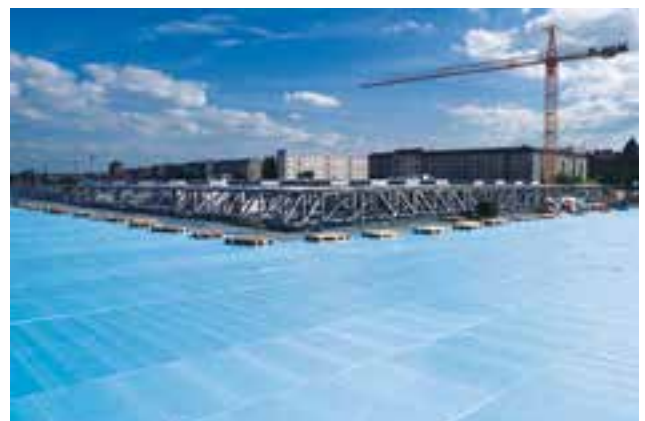
Abb. 10: Die XPS-Dämmplatten schützen während der Bauzeit die darunter liegende Abdichtung
