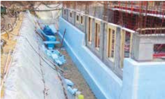
Abb.07: Dämmplatten zweilagig auf der Kelleraußenwand verklebt
