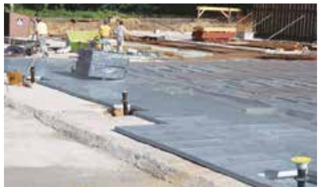
Abb.12: Dämmplatten auf der Beton-Sauberkeitsschicht verlegt
