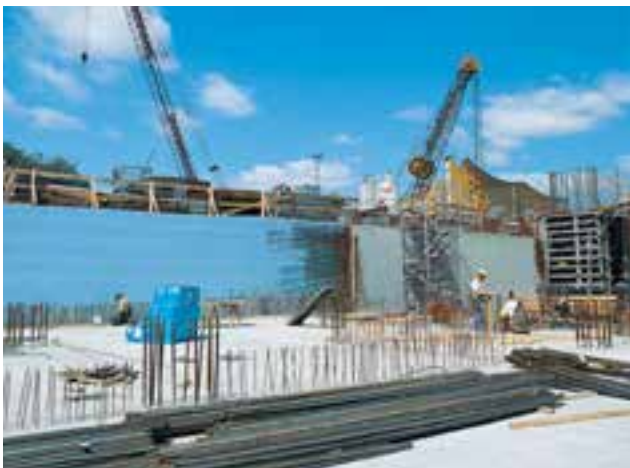
Abb. 29: Die an der Spundwand befestigten Perimeterdämmplatten werden beim Betonieren der Kelleraußenwand als verlorene Schalung genutzt
