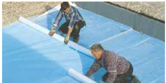
Abb. 22: Verlegung der Trennlage
