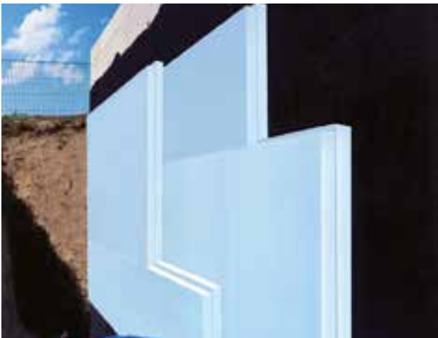
Abb. 15: Mehrlagige Verlegung der RAVATHERM™ XPS Dämmung auf der abgedichteten Kellerwand
