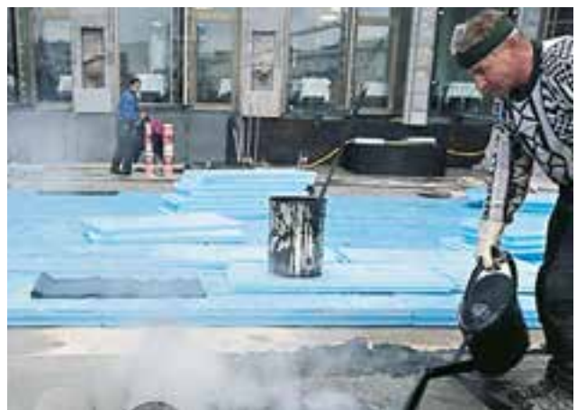
Abb. 11: Verlegebeispiel einer bituminösen, vollflächig verklebten Abdichtung
