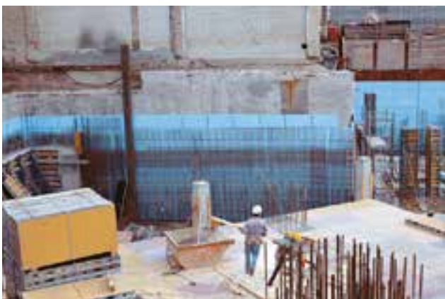
Abb. 30: Die Perimeterdämmplatten sind am Verbau befestigt, der als verlorene Schalung genutzt wird
