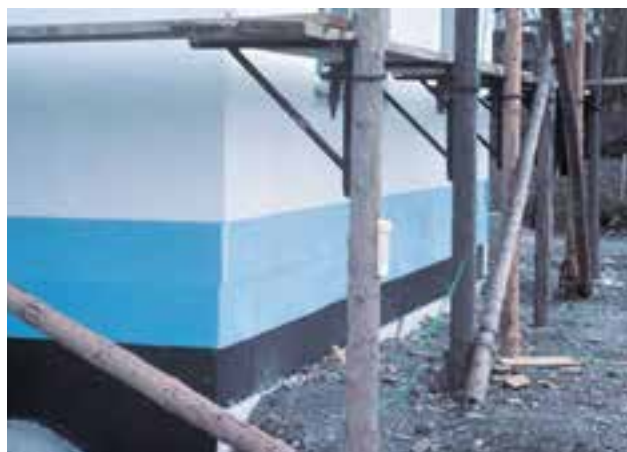
Abb. 43: XPS-Sockeldämmung im Spritzwasserbereich
