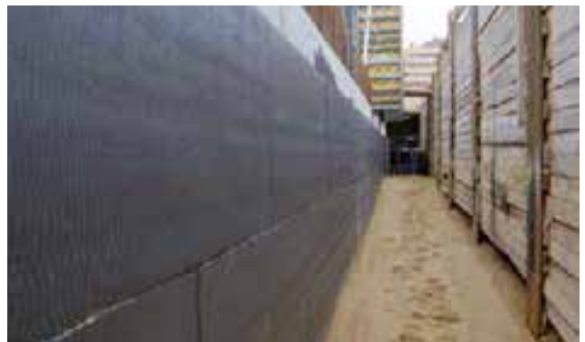
Abb. 11: Graue XPS Dämmplatten auf der Kelleraußenwand verklebt
