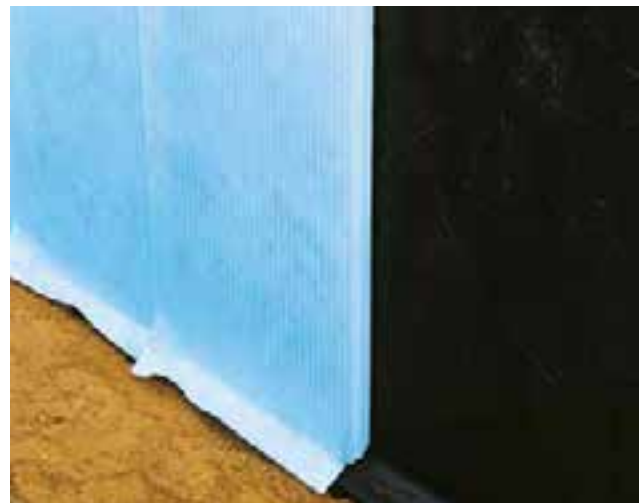
Abb. 37: Am Fußpunkt stehen die XPS Platten auf dem Fundamentvorsprung
