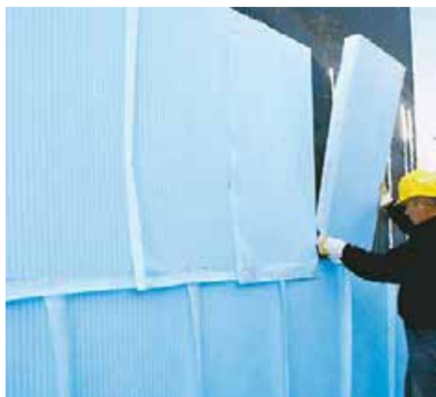
Abb. 34: Verlegung der blauen XPS Dämm-/Dränelemente
