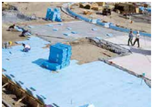
Abb. 20: Verlegung XPS-Dämmplatten unter lastabtragender Bodenplatte
