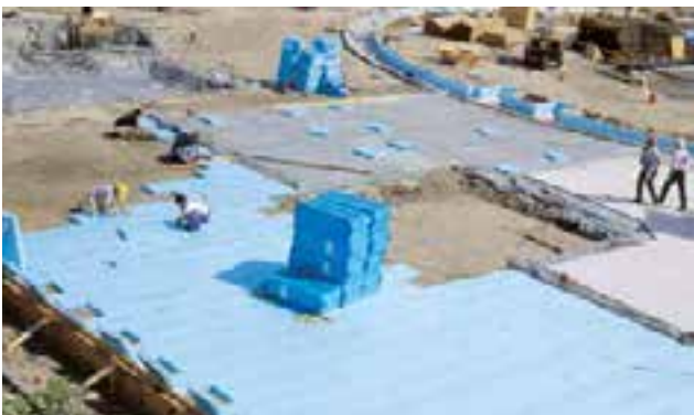
Abb. 10: XPS Dämmplatten lose auf der Beton-Sauberkeitsschicht verlegt
