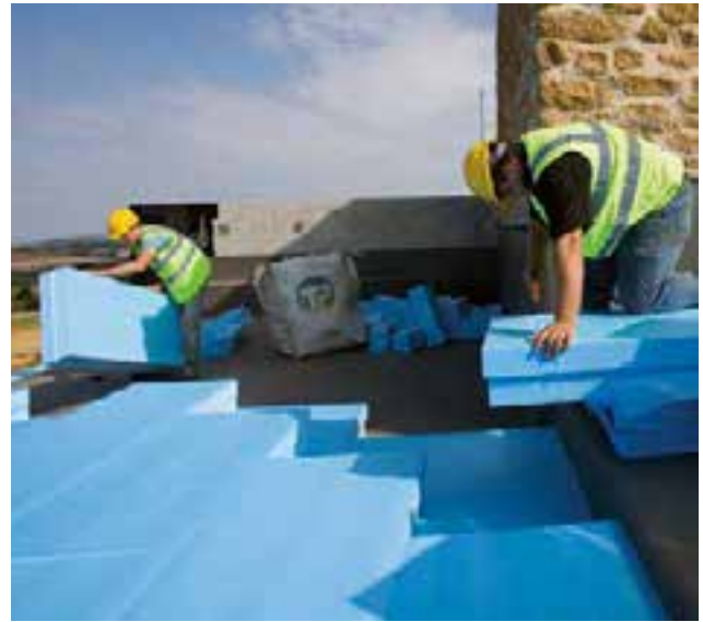
Abb. 22: Die doppellagige Verlegung von XPS Platten auf einer Sauberkeitsschicht aus Beton
