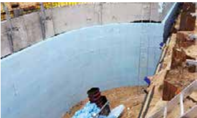
Abb. 12: Dämmplatten auf der Kelleraußenwand verklebt
