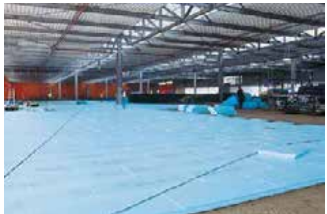
Abb. 39: XPS Bodendämmung in einer Werkshalle
