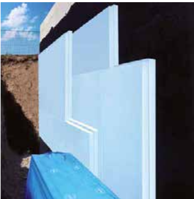
Abb. 16: Mehrlagige Verlegung der RAVATHERM™ XPS Dämmung auf der abgedichteten Kellerwand
