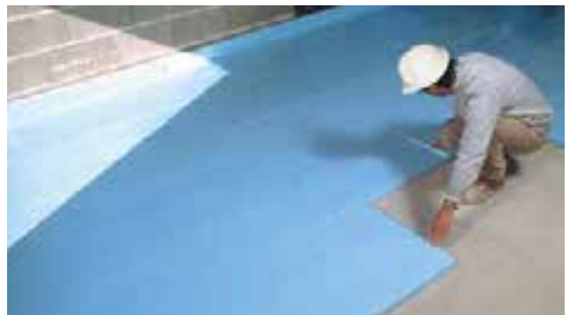
Abb. 46: XPS-Bodendämmung in einer Sporthalle
