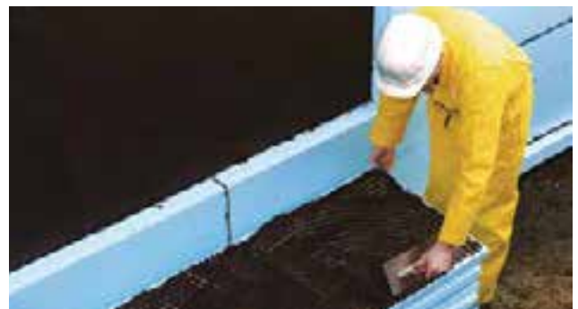
Abb. 32: Vollflächige Verklebung der blauen XPS Dämmung
