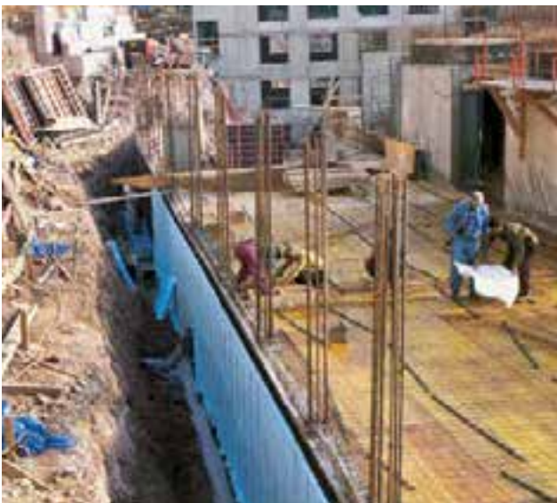
Abb. 35: Einsatz der blauen Dämm-/Dränelemente in über 8m Einbautiefe
