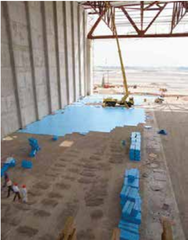
Abb. 40: Die blaue XPS-Bodendämmung wird auf dem Feinplanum verlegt
