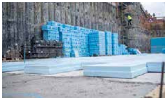
Abb. 13: Dämmplatten auf der Beton-Sauberkeitsschicht verlegt
