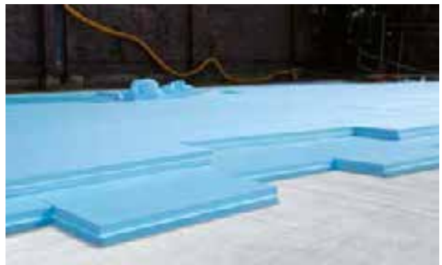
Abb. 19: Zweilagige Verlegung der Dämmplatten auf Sauberkeitsschicht in Beton
