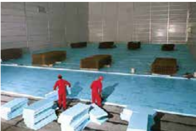
Abb. 38: XPS Bodendämmung in einem Tiefkühlhaus
