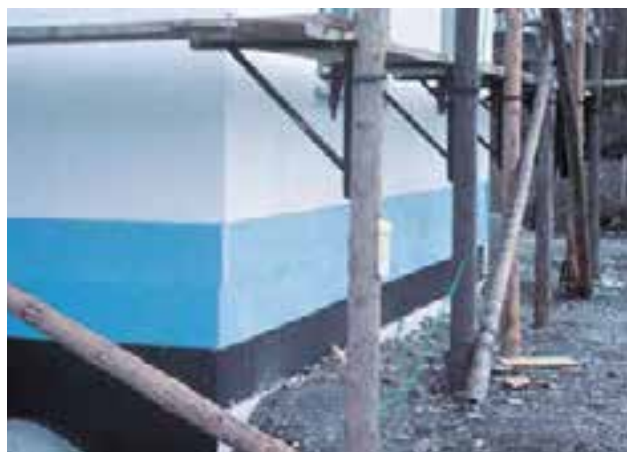
Abb. 43: XPS-Sockeldämmung im Spritzwasserbereich
