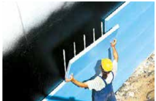
Abb. 26: Verlegung der XPS Dämmung auf der abgedichteten Kellerwand
