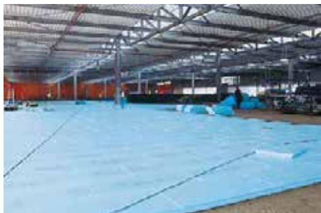
Abb. 39: XPS Bodendämmung in einer Werkshalle
