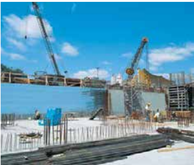
Abb. 29: Die an der Spundwand befestigten Perimeterdämmplatten werden beim Betonieren der Kelleraußenwand als verlorene Schalung genutzt
