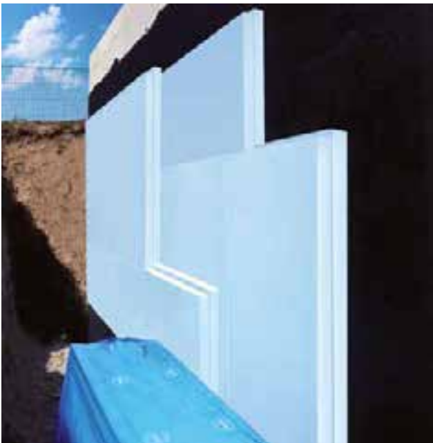
Abb. 16: Mehrlagige Verlegung der RAVATHERM™ XPS Dämmung auf der abgedichteten Kellerwand
