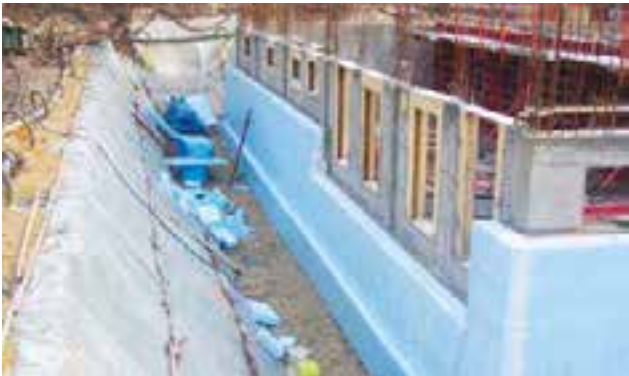
Abb. 08: Dämmplatten zweilagig auf der Kelleraußenwand verklebt
