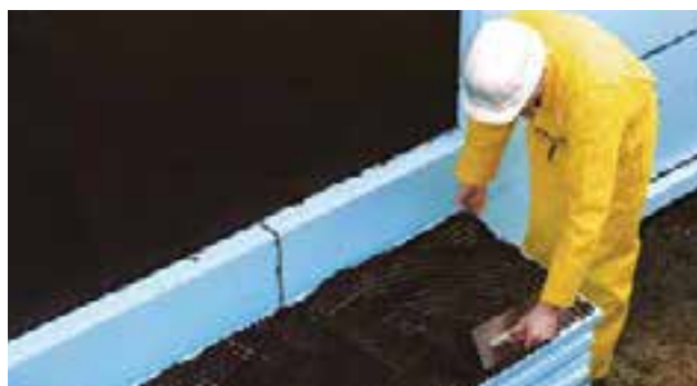
Abb. 32: Vollflächige Verklebung der blauen XPS Dämmung
