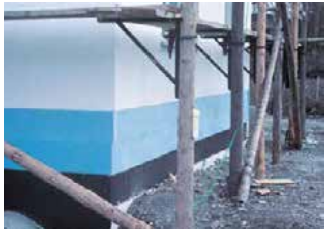
Abb. 43: XPS-Sockeldämmung im Spritzwasserbereich
