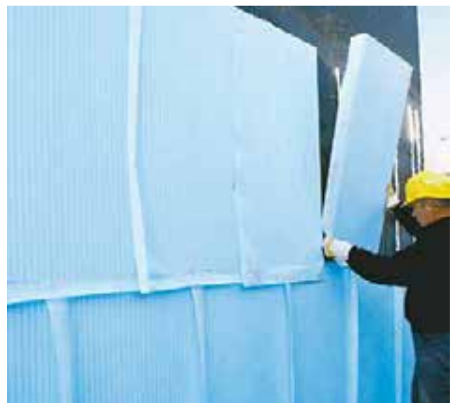
Abb. 34: Verlegung der blauen XPS Dämm-/Dränelemente
