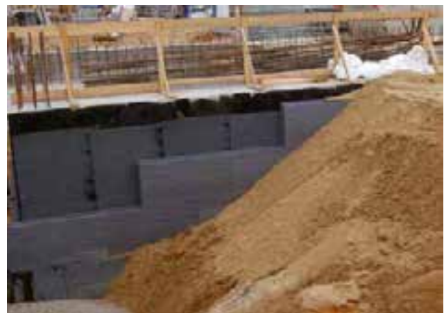
Abb. 18: Verklebung der XPS Dämmplatten auf der abgedichteten Kelleraußenwand
