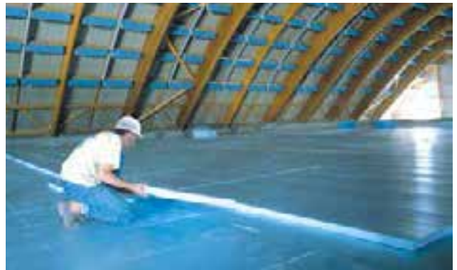
Abb. 45: XPS-Bodendämmung in einer Sporthalle
