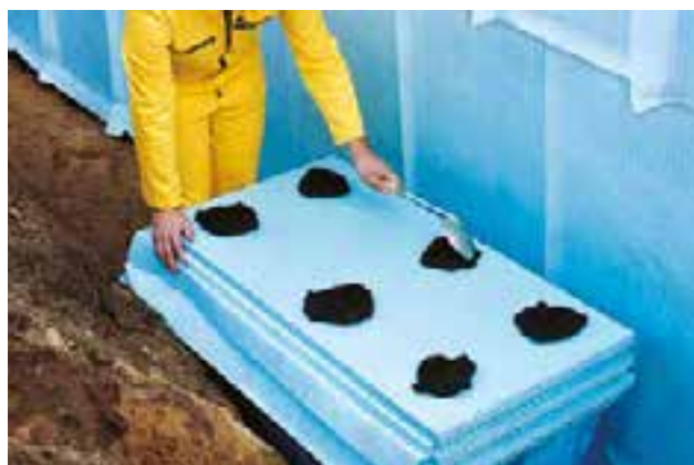
Abb. 28: Punktweise Verklebung der Perimeterdämmung
