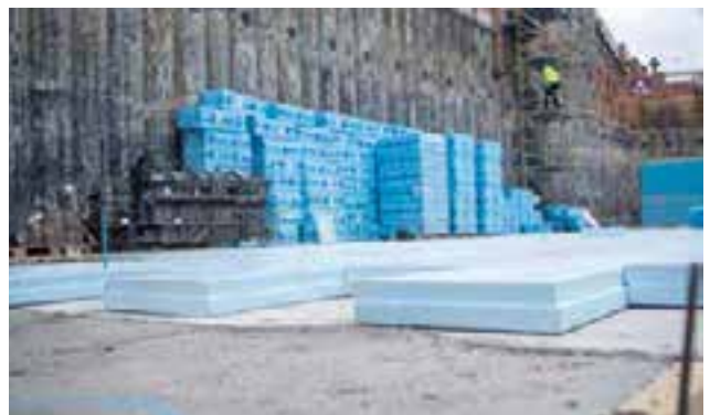
Abb. 13: Dämmplatten auf der Beton-Sauberkeitsschicht verlegt
