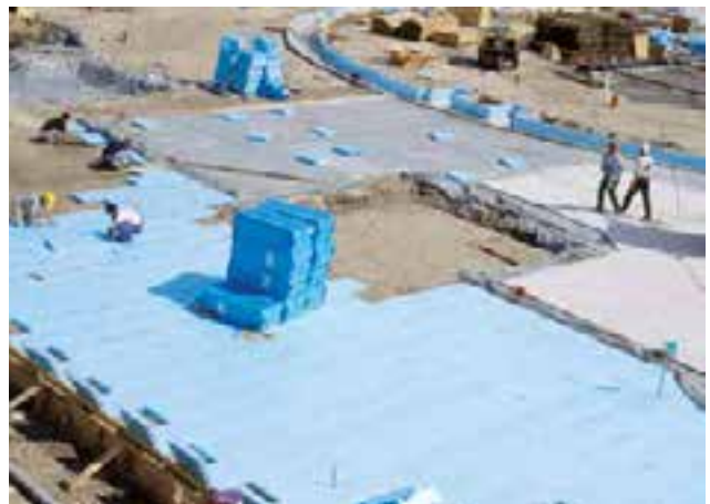
Abb. 20: Verlegung XPS-Dämmplatten unter lastabtragender Bodenplatte
