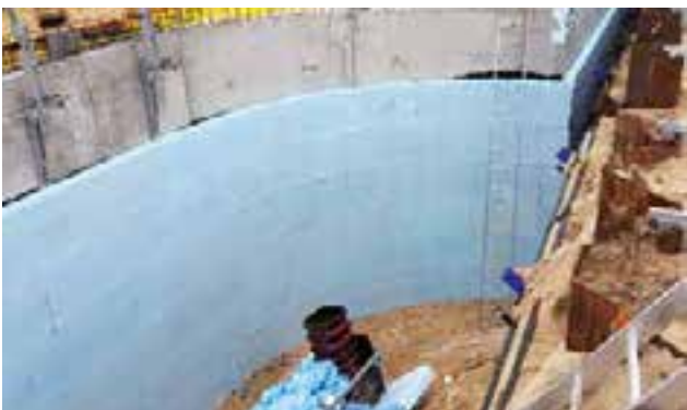
Abb. 12: Dämmplatten auf der Kelleraußenwand verklebt
