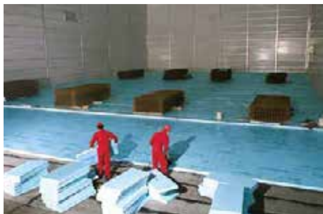
Abb. 38: XPS Bodendämmung in einem Tiefkühlhaus
