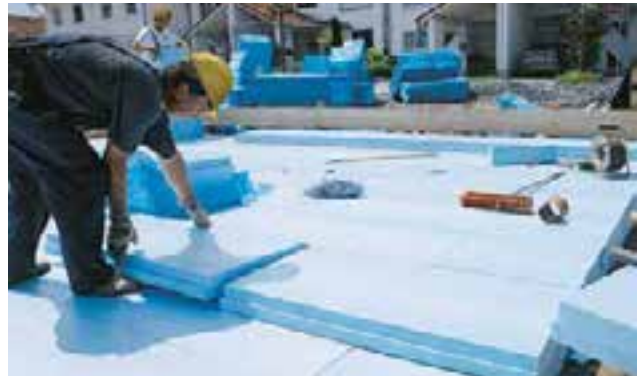
Abb. 09: Blaue XPS Dämmplatten mehrlagig auf das Feinplanum verlegt
