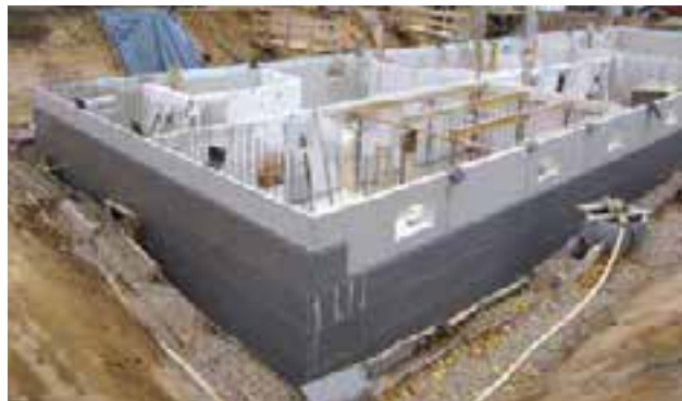
Abb. 27: Verlegung der grauen XPS Dämmplatten auf der Kelleraußenwand in WU-Beton
